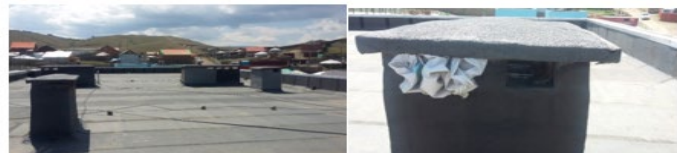
Зураг 15. Сургуулийн хооллох залны агаар сорох системийн сэнс, зонтоор сорсон агаарыг зайлуулж буй шахт (эхний том сараалж)
