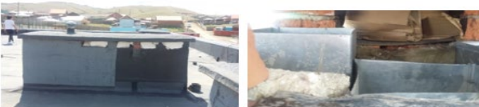
Зураг 16. Ердийн агаар сорох системийн зайлуулах шахт, түүнийг бөглөсөн байдал
