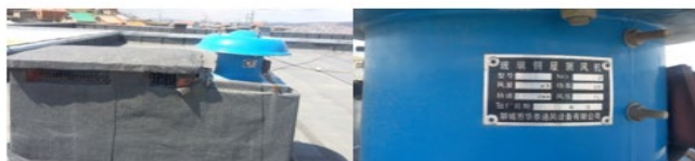
Зураг 15. Сургуулийн хооллох залны агаар сорох системийн сэнс, зонтоор сорсон агаарыг зайлуулж буй шахт (эхний том сараалж)
